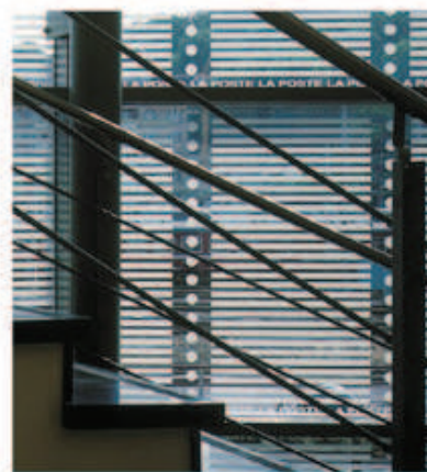
Třídicí centrum, Liege. - Architekt : L'Atelier
